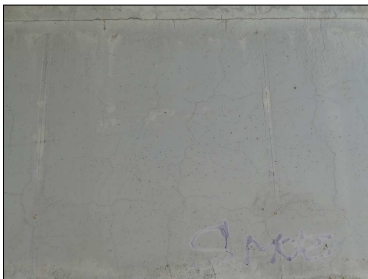
Obr. č. 4 – Opěra O 01 – trhliny v betonové části dříku
