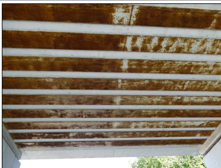
Obr. č. 3 – Konstrukce K 02 – koroze dolních pásnic nosníků
