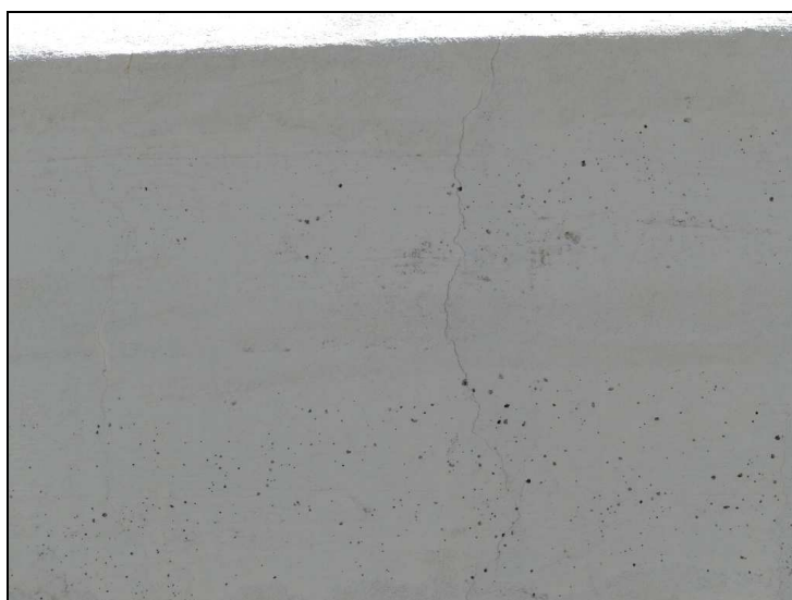
Obr. č. 2 – Konstrukce K 01 – vlevo z boční strany – svislá trhlina
