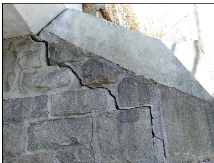
Obr. č. 6 – Opěra O 02 – křídlo vpravo – stupňovitá trhlina
