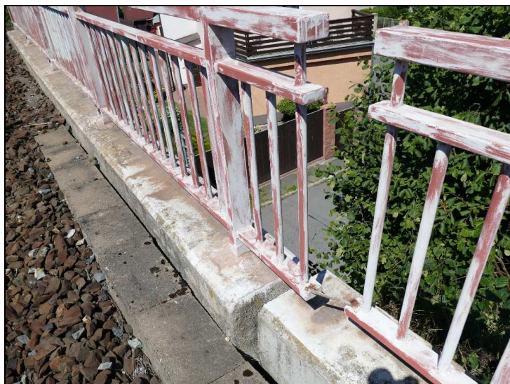
Obr. č. 5 – Opěra O 01 – přechodová zídka vpravo – odtržená, pokleslá a vysunutá
