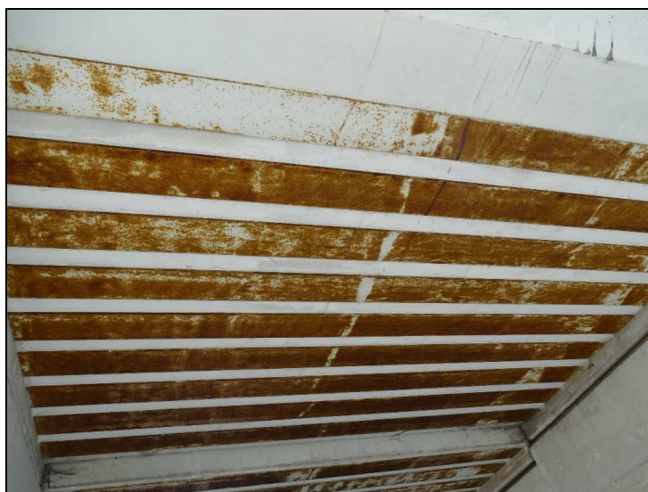
Obr. č. 1 – Konstrukce K 01 – koroze dolních pásnic nosníků
